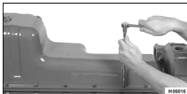
Figura 273 Instalación de los pernos del cárter
