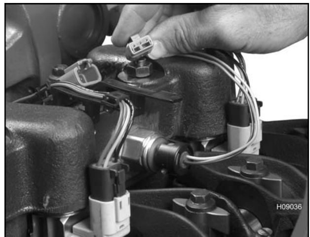
Figura 456 Conexión del BCP
