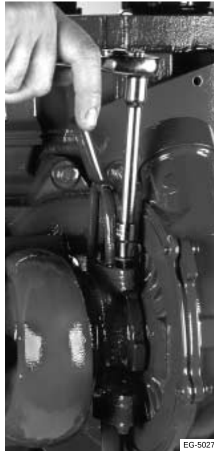
Figura 2.25 Instalación del tubo de suministro de aceite
