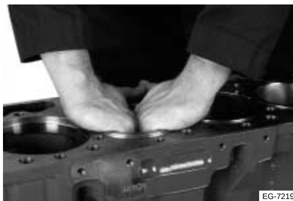
Figura 6.46 Instalación de las camisas
