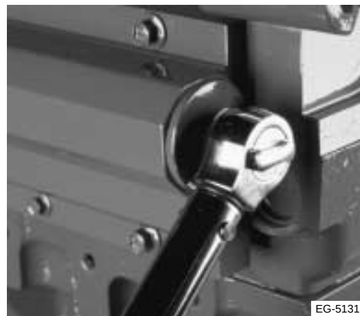
Figura 4.11 Instalación del tapón de extremo
