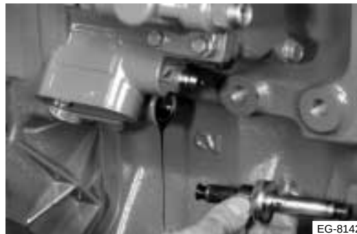
Figura 12.19 Instalación del IPR
