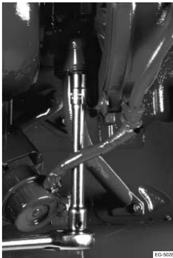
Figura 2.27 Instalación del tubo de drenaje de aceite
