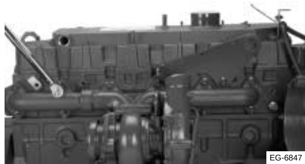
Figura 3.7 Instalación del múltiple de escape
