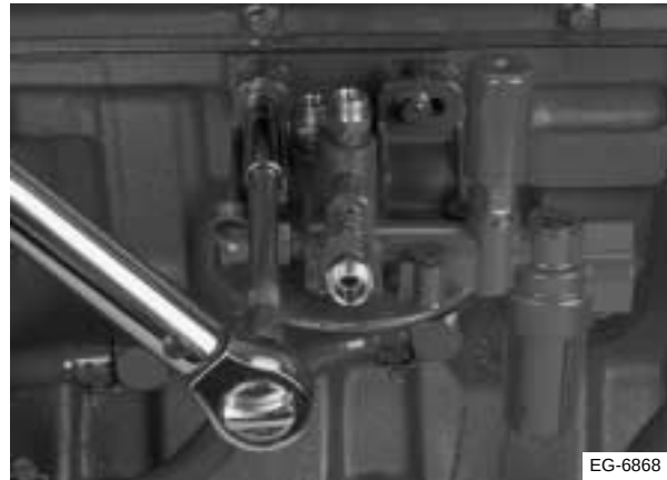
Figura 13.11 Instalación del cabezal del filtro
