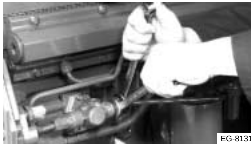
Figura 13.4 Retiro de la tubería de suministro
