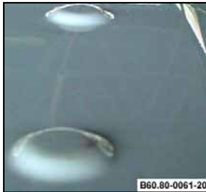
Saliências do teto da cabine
